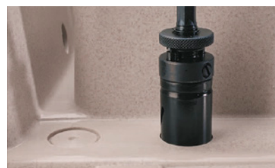
C - Procedere con il completamento del foro
